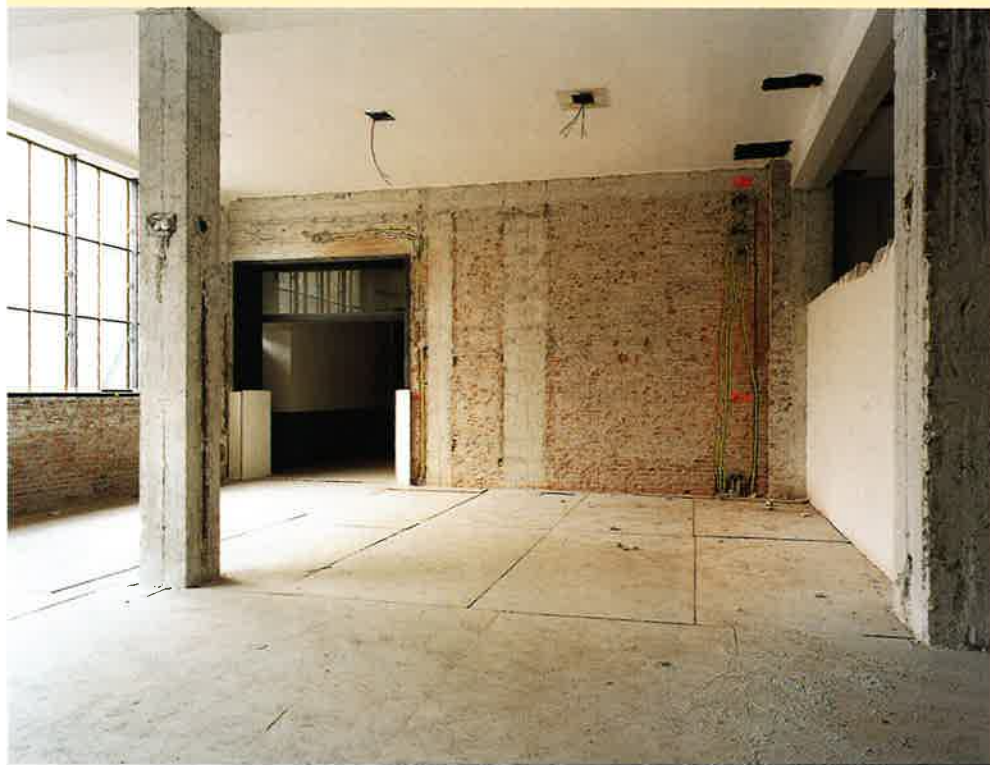
De wanden in het interieur zonder bespanning; zichtbaar is het betonskelet met metselwerk van zacht gebakken stenen waarin eenvoudig spijkers geslagen konden worden voor het ophangen van de schilderijen
