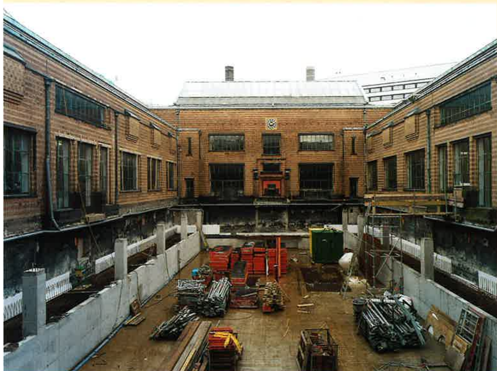
De bouw van de souterrainruimte onder het binnenhof. Hier zal de modecollectie geëxposeerd worden
