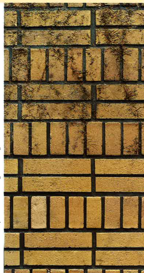
Proefstuk buitengevel, aan de onderzijde schoongemaakt en boven nog met sporen van een klimplant
